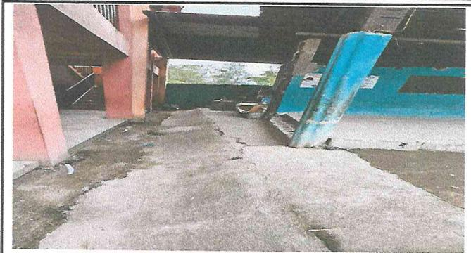
Foto 2: NIVELACION DE GRADA EN COCINA Y FUNDICION DE LOSA
